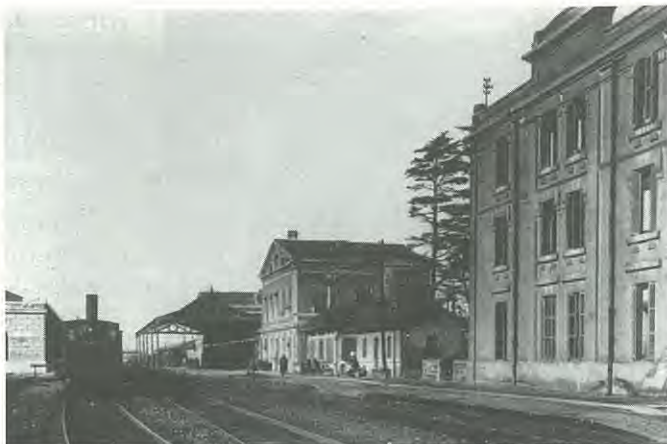
Sobre los antiguos vestigios del Carmelo se edificó la estación de ferrocarriles. (Foto Gómez Vidal).
